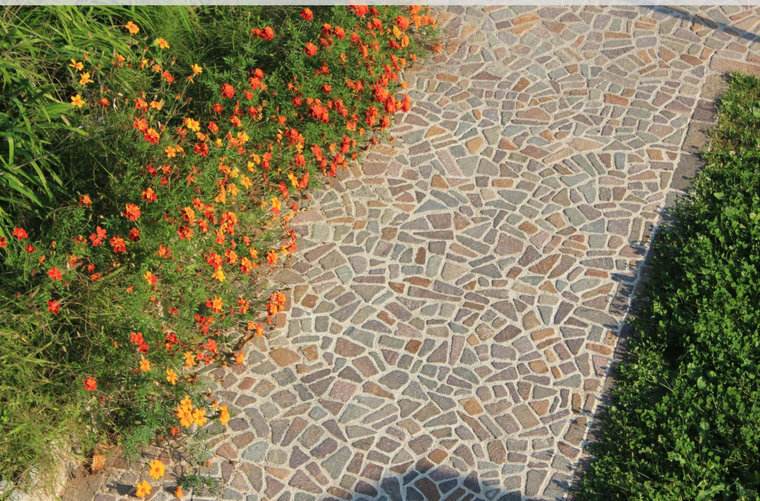
L'anticatura del Porfido è un processo piuttosto recente ed è nato principalmente per offrire una valida alternativa al selciato classico. Ottenuta tramite un processo di rotolamento lento e costante che interviene sul piano superficiale, sulle coste e sugli spigoli vivi delle pezzature di Porfido.
